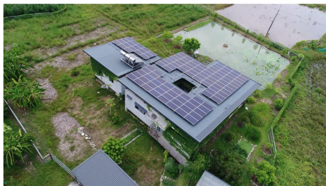
住宅屋頂-王家綠能宅 台南
