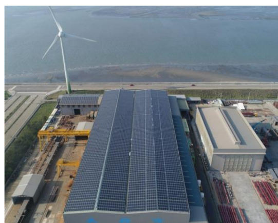
企業廠房屋頂-大將作工業股份有限公司
